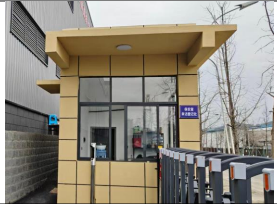
主体建筑物 (2026年2月)
