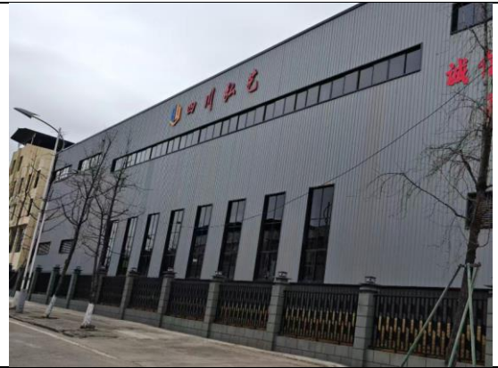
主体建筑物 (2026年2月)
