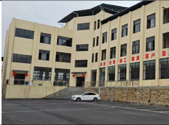
主体建筑物 (2026年2月)
