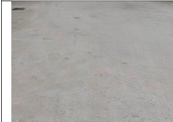
硬化地面现状 (2026年2月)
