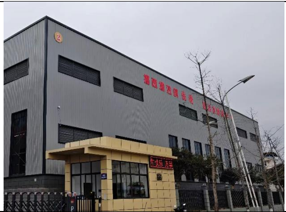
主体建筑物 (2026年2月)
