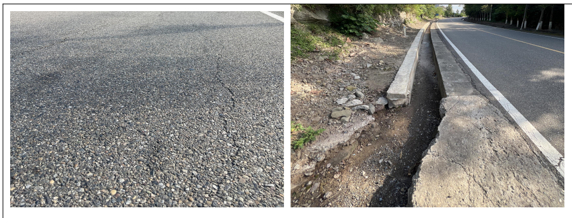
现状路基路面情况
