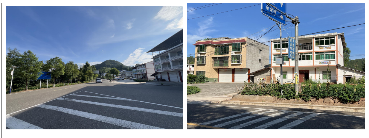
路线起点及沿线建筑物
