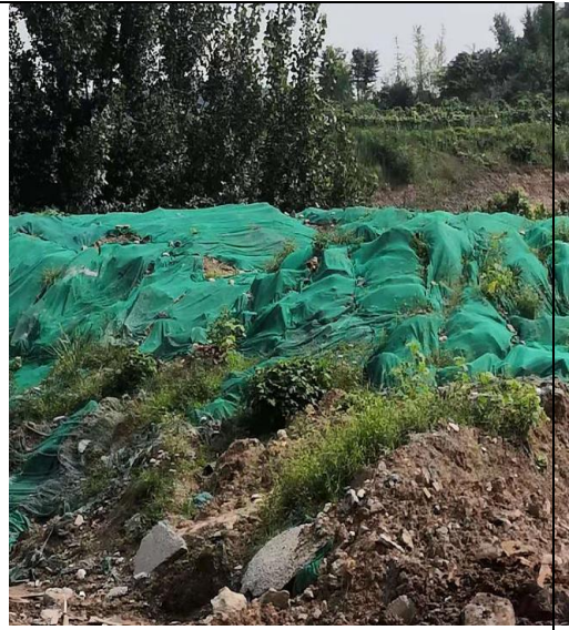
临时堆土覆盖
