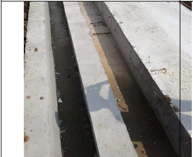
主体工程排水沟
